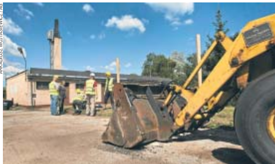
Prace przygotowawcze na działce już trwają, budowa ruszy w lipcu
